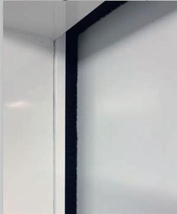
Porte assemblée sur précadre alu avec joint pour une étanchéité et une longévité optimisée
